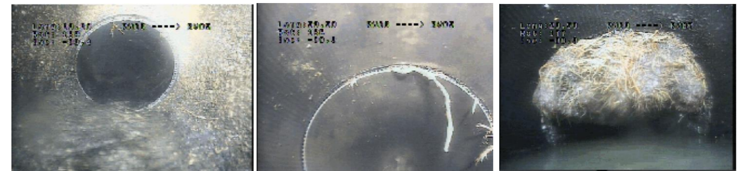
Illustration n°10 : Regard n°11 bis, 12 et 13 non étanches
