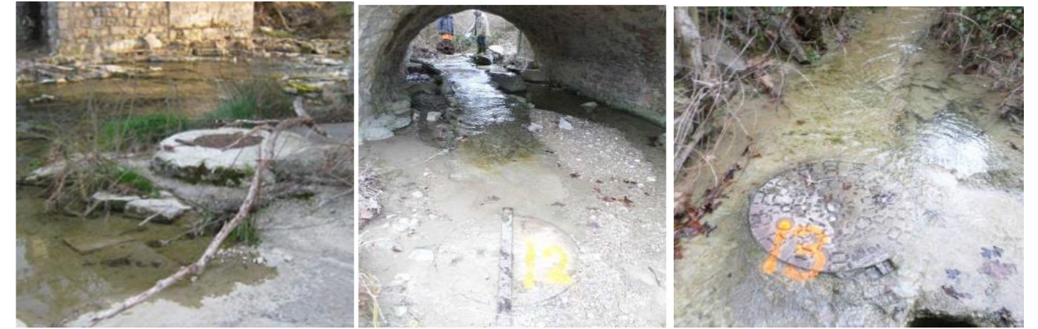
Illustration n°9 : Regard n°11 bis, 12 et 13 non étanches – cliquez sur la photo pour visualiser le film
