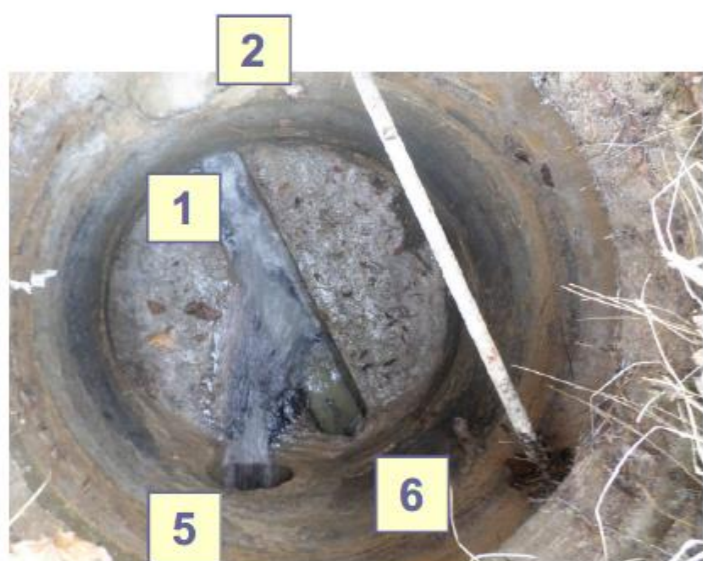
Illustration n°1 : Regard n°23 : déversoir d'orage fonctionnant en sens inverse par arrivée n°5. Vidéo du DO Cliquez sur la photo ci-dessus
