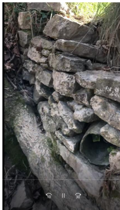
Illustration n°1 : Regard n°23 : déversoir d'orage fonctionnant en sens inverse par arrivée n°5. Vidéo du DO Cliquez sur la photo ci-dessus
